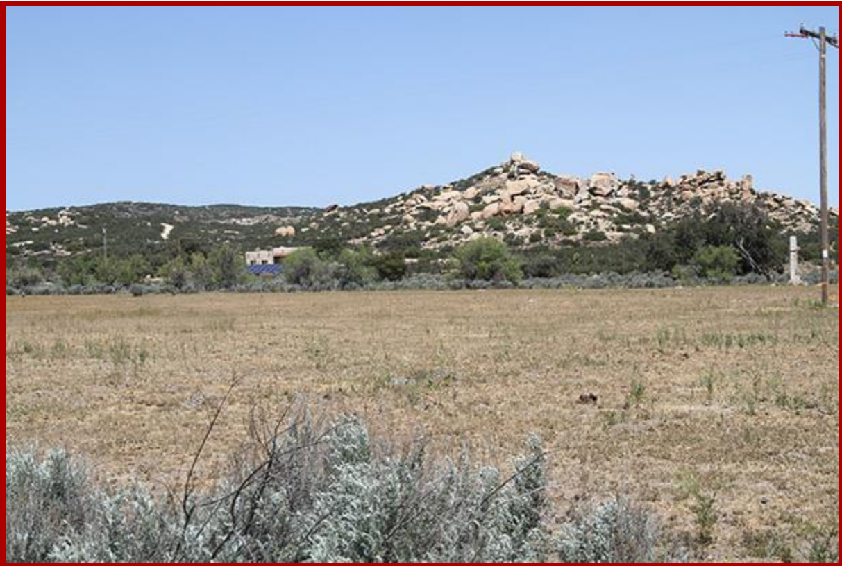
Fig. 16 Site of Soitec LanWest Solar.
