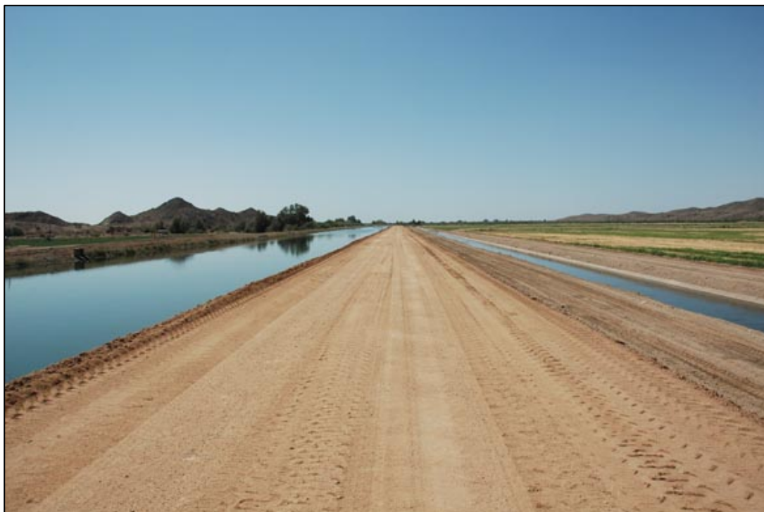
Figura 4.- Canal de irrigación (izquierda) y canal de drenaje (derecha), irrigación Wellton-Mohawk, Arizona.
