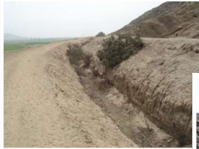
Canal San Antonio
